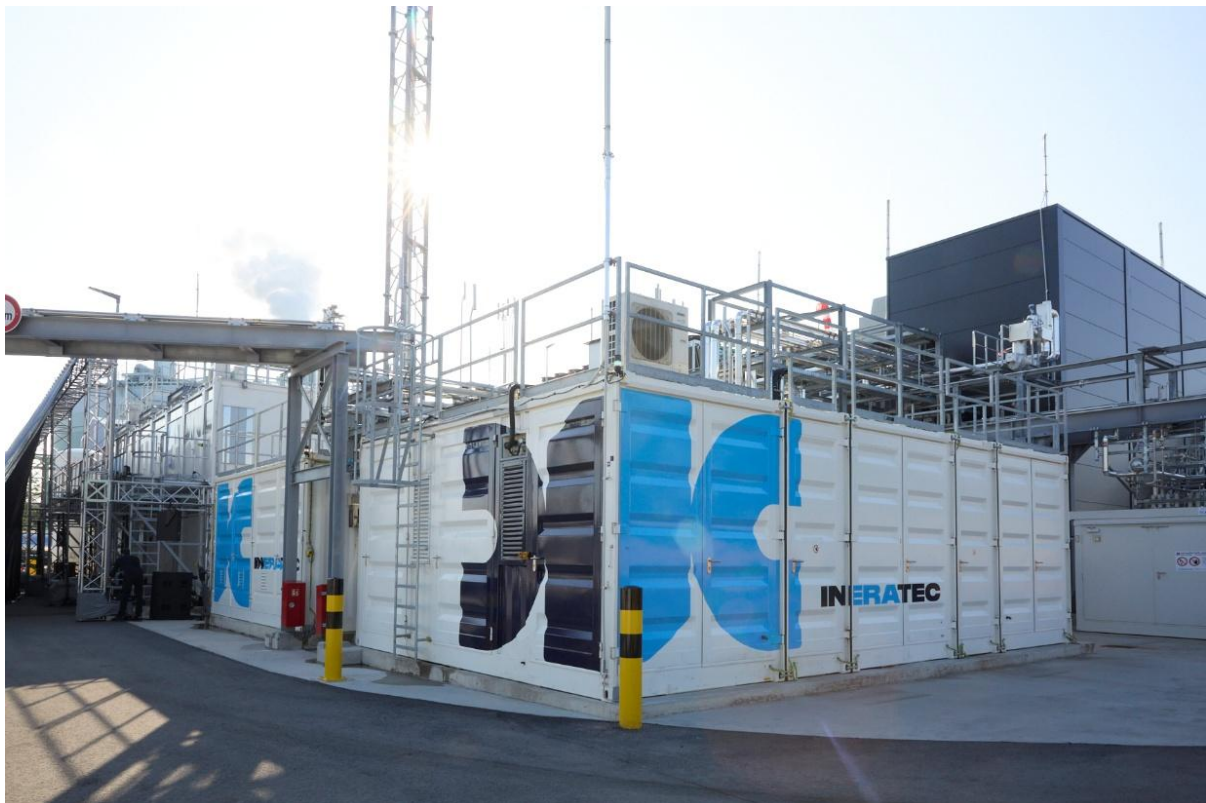
ERA ONE – INERATECs Power-to-Liquid-Anlage in Frankfurt, Europas größte in Betrieb befindliche e-Fuel-Anlage auf Basis der Fischer-Tropsch-Synthese. © INERATEC
